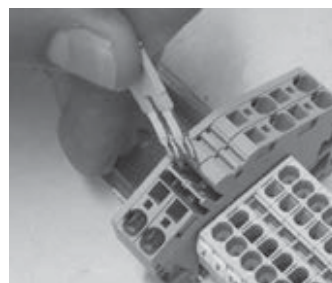
Удаление шунта для деактивации электронагревателя (снижение мощности на 1000 Вт)
