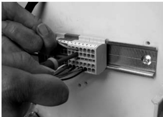
Заказчик должен подключить скорости к термостату, расположенному в верхней части блока электрических подключений между V1 и V5.
